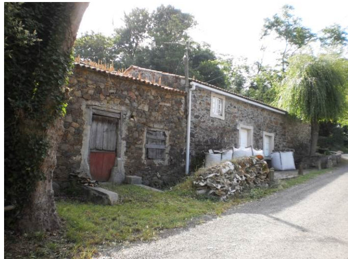
Construcións tradicionais con forno en Alborelle (Soñeiro)
