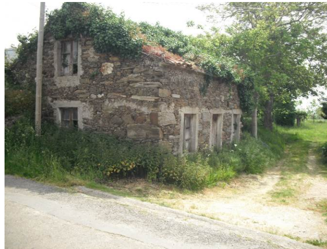
Construción orixinal en ruínas en Muíño do Vento, Meirás
