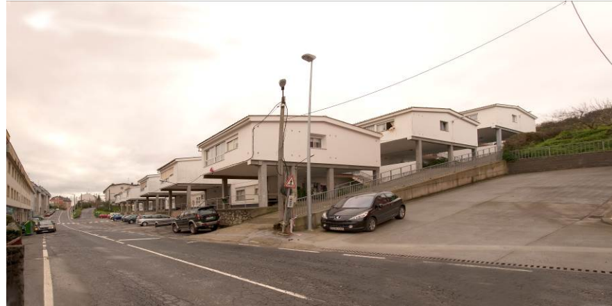
Urbanización en Fontán
