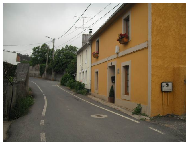
Edificacións orixinais en Machado, Mosteirón
