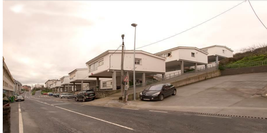
Urbanización en Fontán
