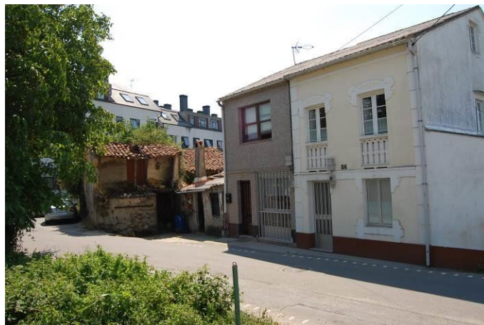
Encontro entre o núcleo tradicional de Sada de Arriba e o tecido urbano ó fondo
