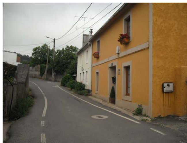
Edificacións orixinais en Machado, Mosteirón
