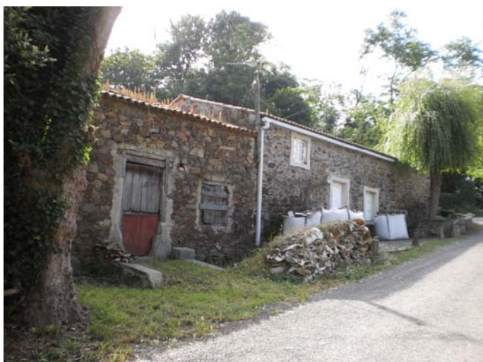
Construcións tradicionais con forno en Alborelle (Soñeiro)
