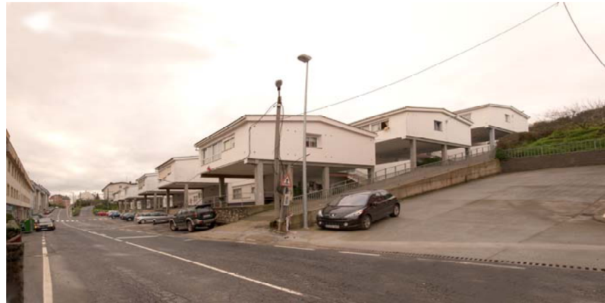
Urbanización en Fontán
